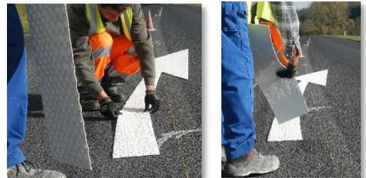
Il suffit de positionner le morceau n°2 et les 6 autres s'alignent ensuite parfaitement
